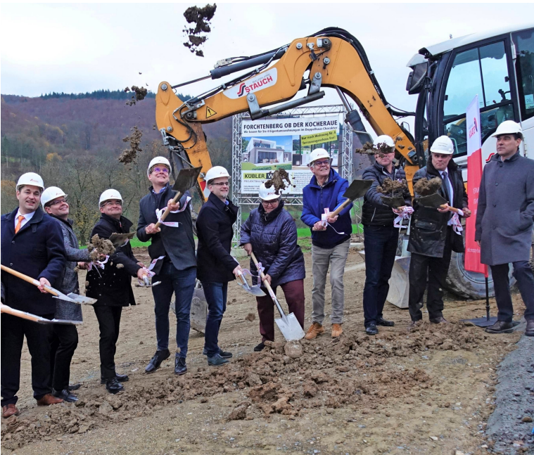
Beim symbolischen Spatenstich wurde die große Vorfreude der Beteiligten über den Baubeginn des außergewöhnlichen Projektes deutlich. Foto: Juergen Koch
