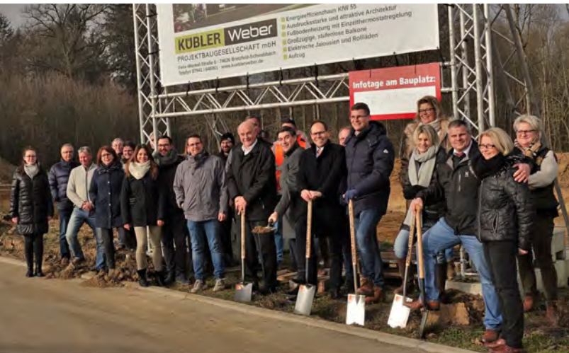
Direkt an der bereits ausgehobenen Baugrube feierten gestern Markus Kübler und Claus-Peter Weber mit Kunden und Partnern den Baustart.
